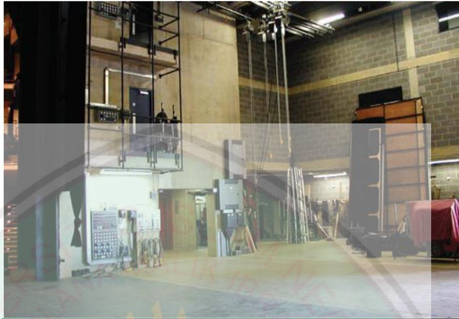
Gambar 2.24 Lampu dengan Sistem Rel Tarik
