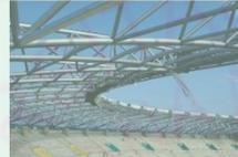
STRUKTUR RANGKA BATANG
