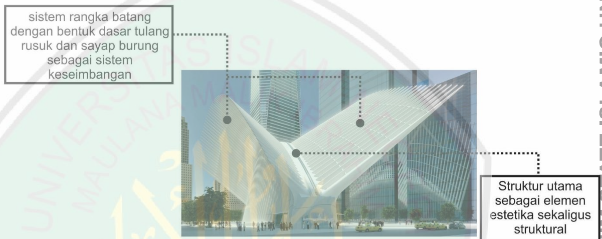
Gambar 2.41: struktur pada bangunan
