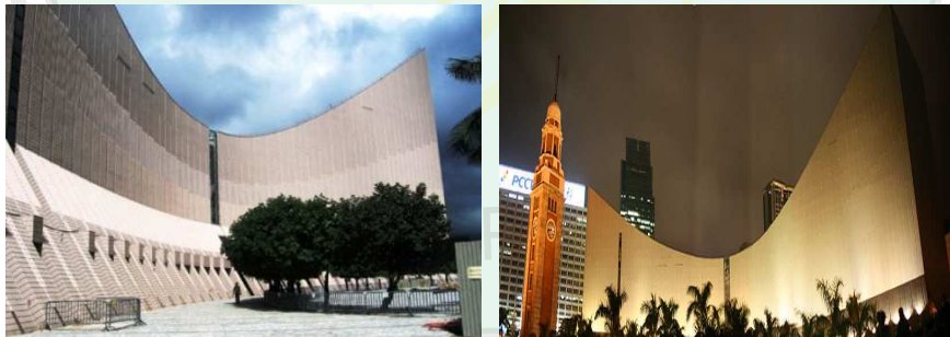
Gambar 2.27 Dinding eksterior pada bangunan
