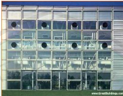
**Gambar 2.22** Sainsbury Center, fasade bangunan menggunakan material kaca
