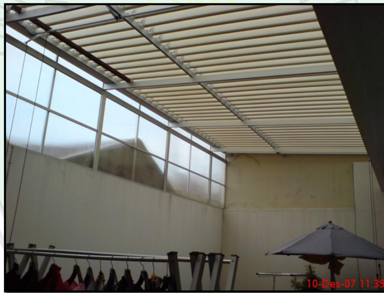
Gambar 2.45 Sistem sunlouver (Sumber: http://www.google.com/ diakses tanggal 17April 2013)
