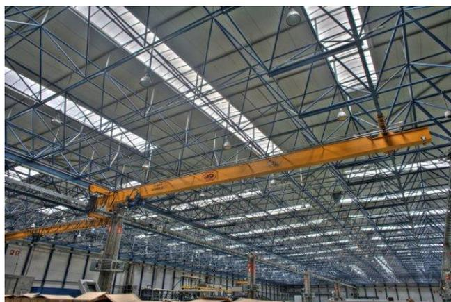
**Gambar 2.49 struktur space frame**
