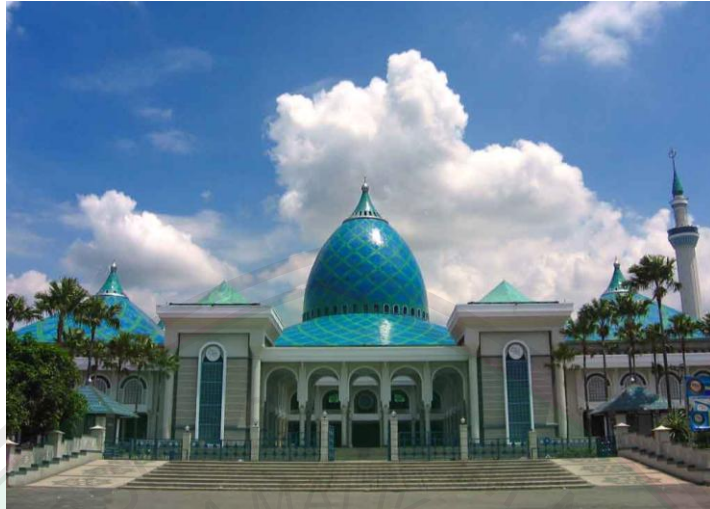
Gambar 2.27 Foto Tampak Depan Masjid Nasional Al Akbar Surabaya (sumber: http://www.rudydewanto.com )
