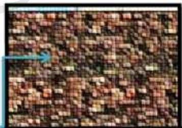
Gambar 4.2: Memanfaatkan batu alam untuk pembatas view keluar, dan sebagai pembatas bangunan, batu alam mampu menyerap suhu panas. (sumber: hasil analisis.2012)
