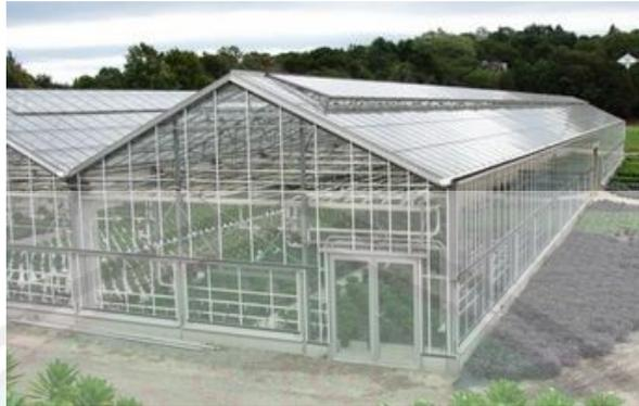
Gambar 2.31 *Greenhouse* tipe multispan
