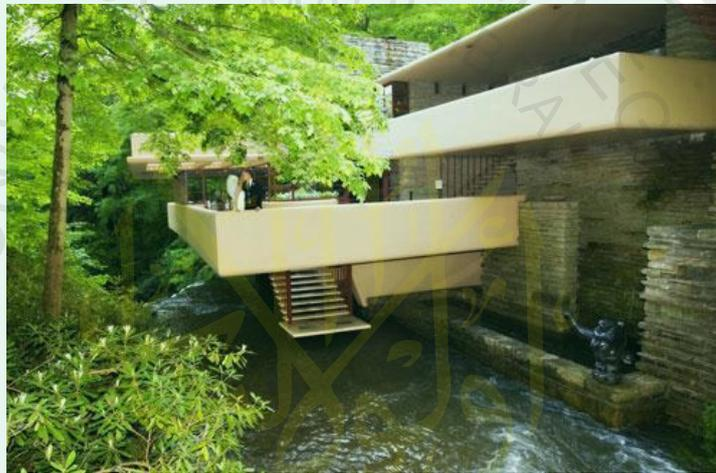
**Gambar 2.28. Bagian *Cantilever* Bangunan**
