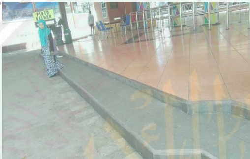
5. tidak ada jalan landai pada pintu masuk
