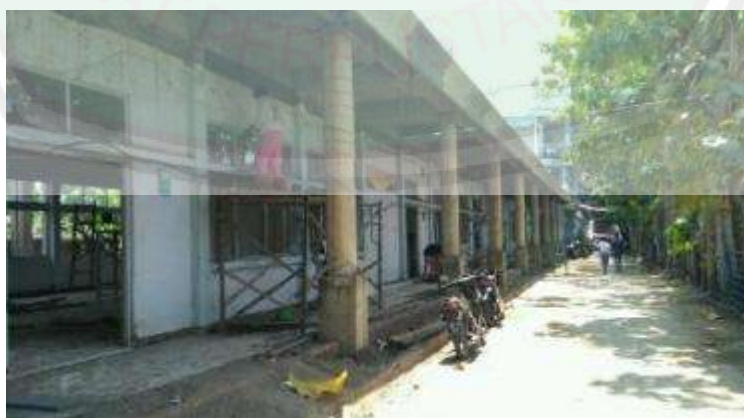
Gambar 4.11. Proses Pembangunan Pusat Kajian Islam berbasis Sains
